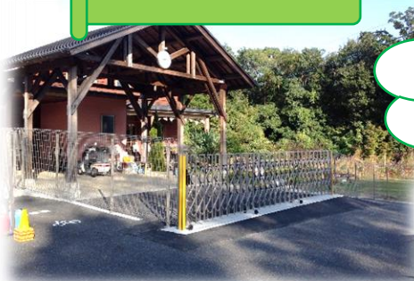
フェンス・門扉新設
